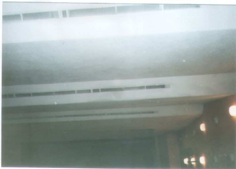
Rys.1 Widok stropu od dołu ze strony sceny
