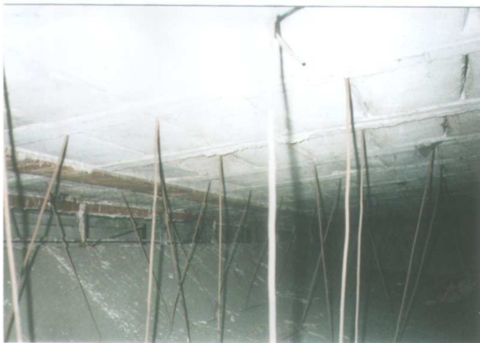
Rys.4 Widok stropu akustycznego od strony stropodachu
